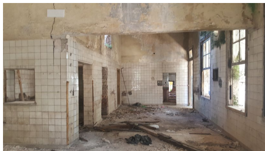
Fig. 9 - Interior pabellón San Camilo
